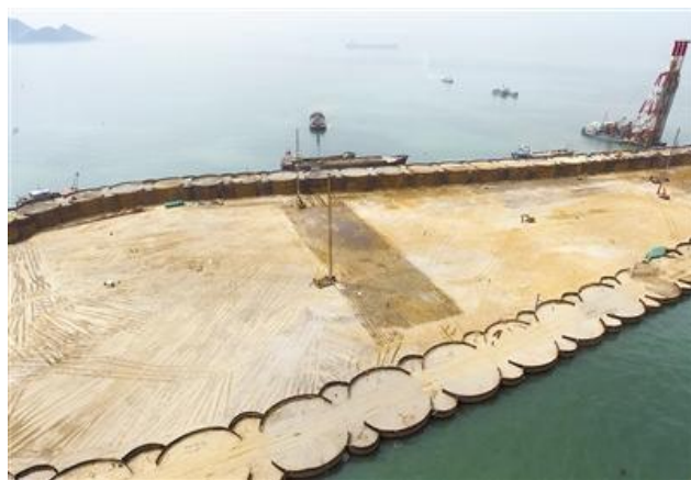
图2: 通过沉管方式建造人工岛
