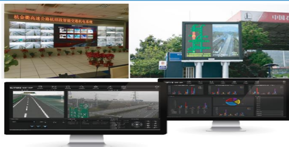
图 23：千方科技高速公路机电工程案例
