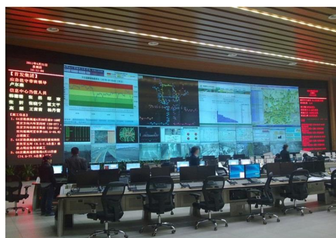
图 17：千方科技城市综合交通运行指挥中心案例
