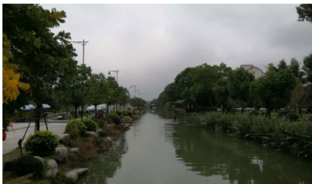
图 7: 浙江奉化滕头村外婆河景观—水生态城市试点验收
