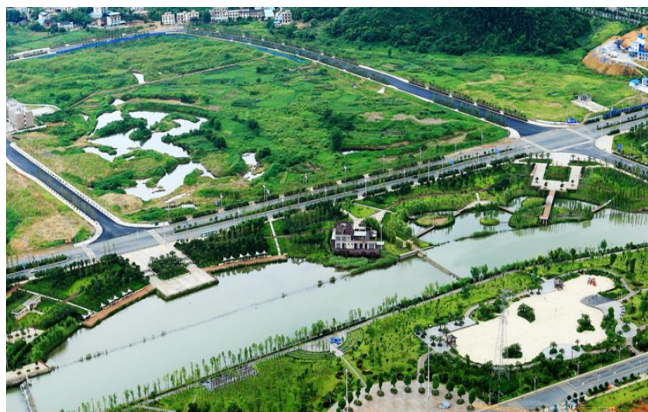
图 17：郴州·西河带状公园及生态治理 BT 融资建设工程
