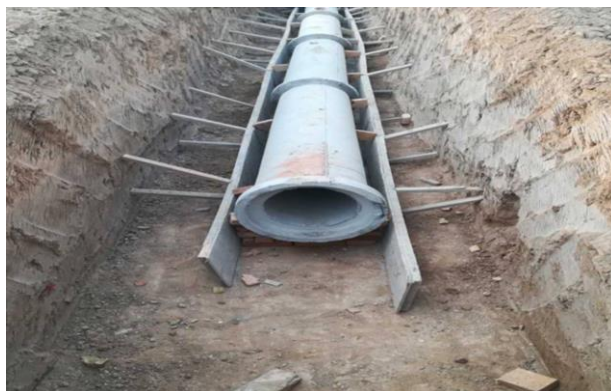
图 8: 陕西林皋镇污水处理厂项目进展--重点项目巡查
