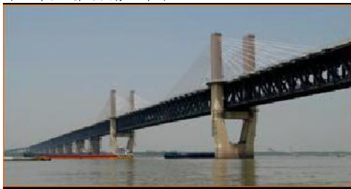
图 5：中铁山桥钢结构产品举例
