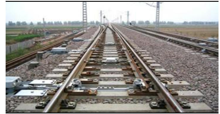
图 27: 中铁宝桥投资 10 亿的高速道岔项目
