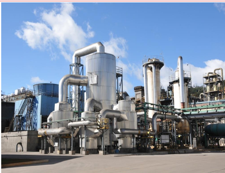
图表 9: 先进的锡冶炼烟气低浓度二氧化硫制酸系统
