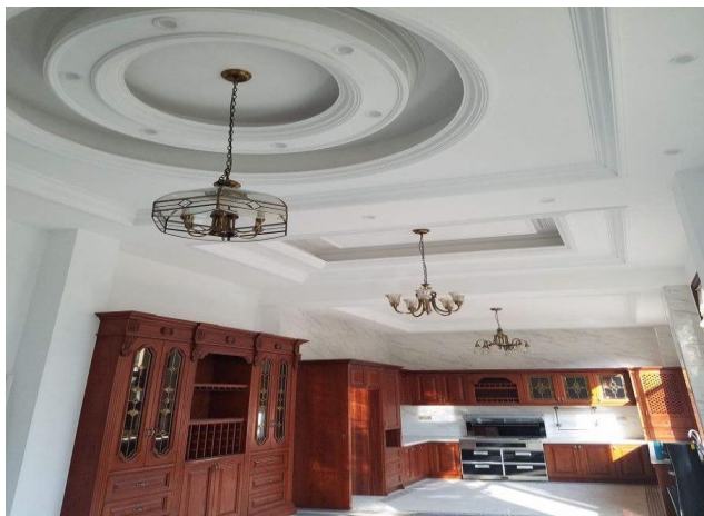
图 19: 石膏板用于吊顶
