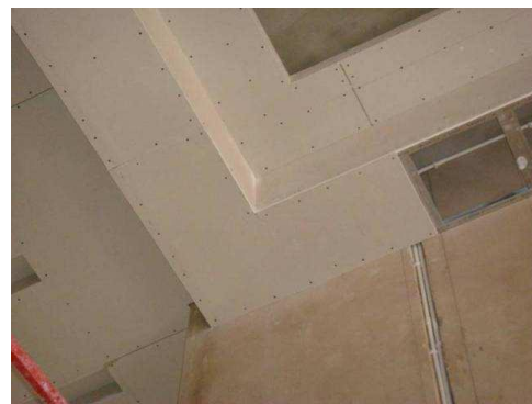
图 8：石膏板天花板吊顶效果
