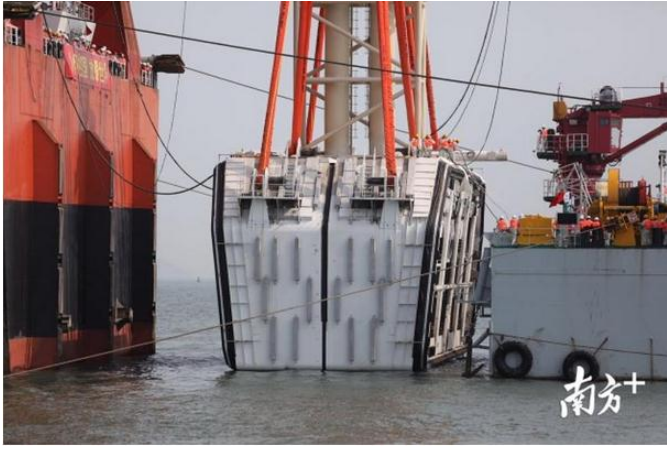
图4: 港珠澳大桥施工现场
