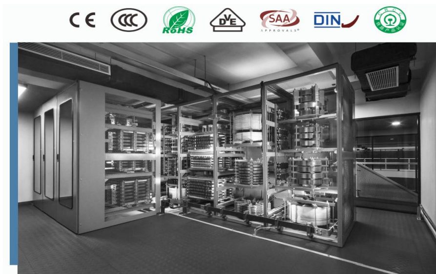
图8: 公司全球顶级低压电器实验室
