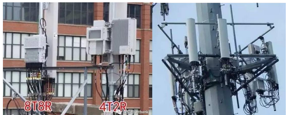
图 25：MIMO 技术提升导致天面资源匮乏
