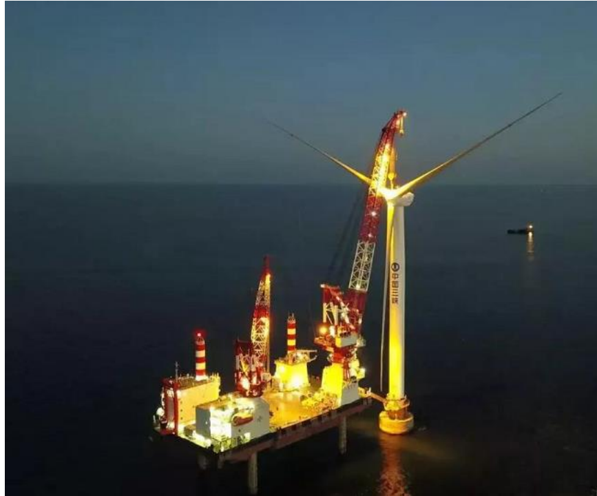
图 4：2013 年-2018 年 1-9 月红六省风电装机量风机吊装现场
