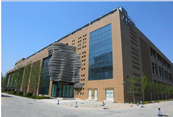
图 30：中经云北京亦庄数据中心外景
