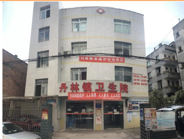
图 1：丹林卫生院旧址外景
