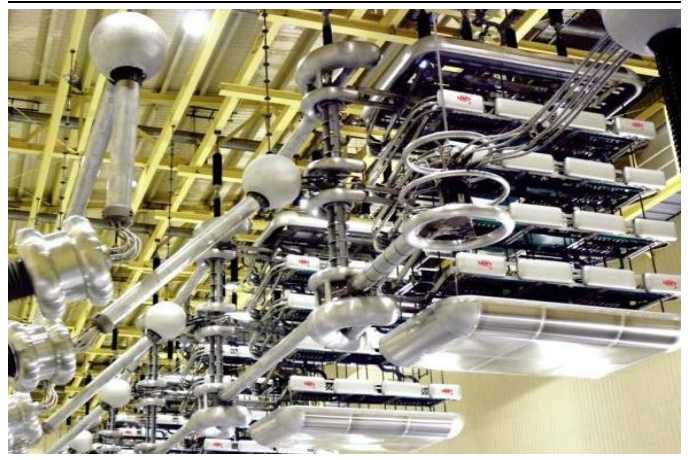
图46: 换流阀示意图
