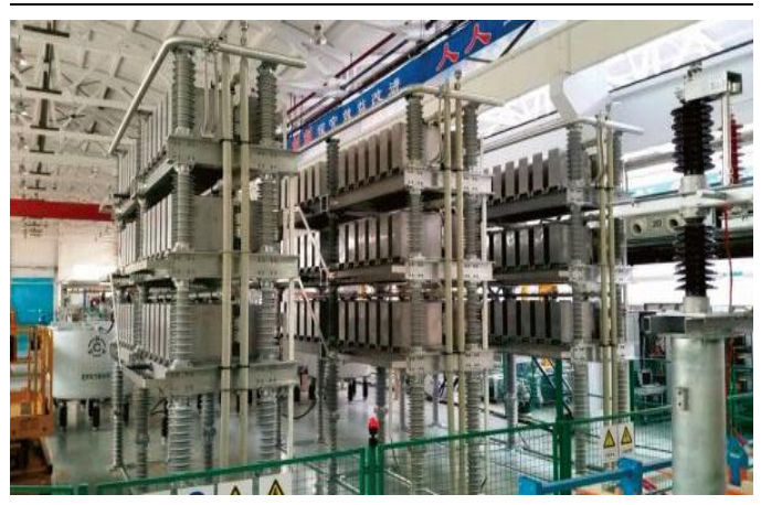
图55: 酒泉-湖南±800kV 特高压直流输电工程±120Mvar STATCOM 设备
