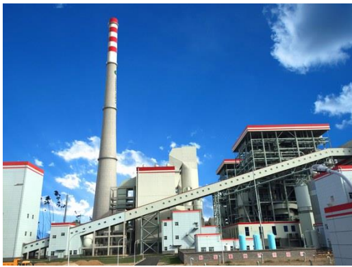
图 24：山西国峰煤电有限责任公司 2 × 300MW 机组烟气超低排放治理工程
