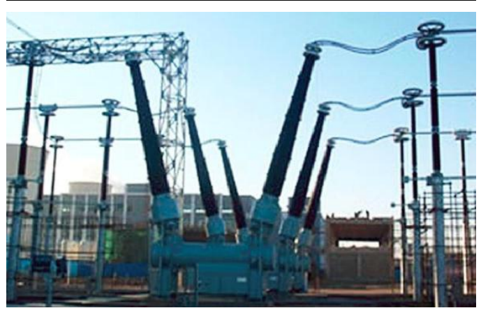
图48: 800kV 电压等级的罐式六氟化硫断路器产品
