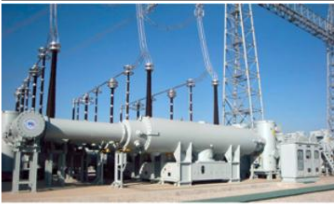
图1: 组合电器示意图
