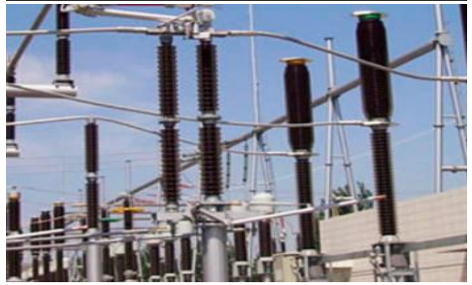
图2: 隔离开关示意图
