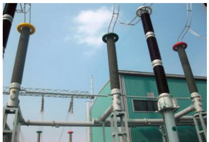
图4: 复合绝缘子示意图
