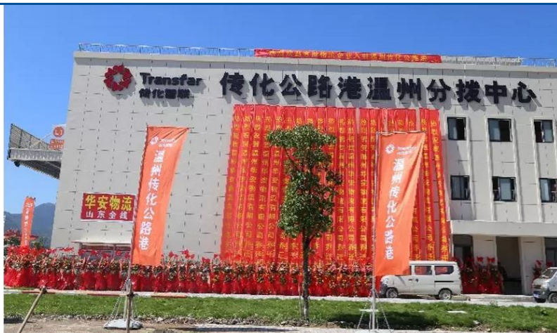
图 17: 传化温州公路港
