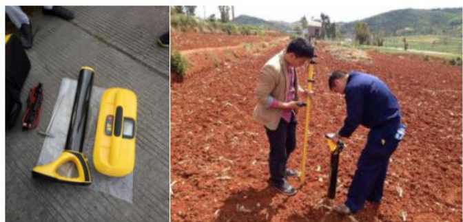
图 7：管线探测仪现场工作
