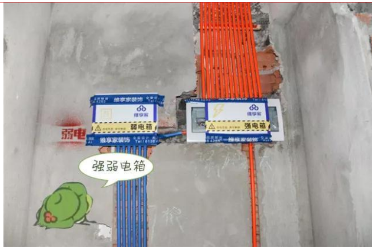
图表 6: 强弱电箱施工示意图
