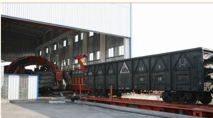
图表 11：公司修建铁路线进入园区
