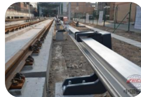
铁路电气化施工
