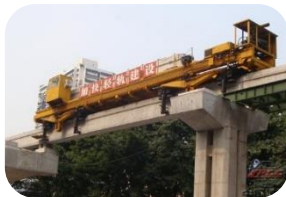
桥梁施工设备
