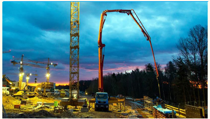
图表 19：混凝土泵车施工图
