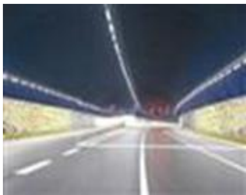
图7：青岛胶州湾公路隧道
