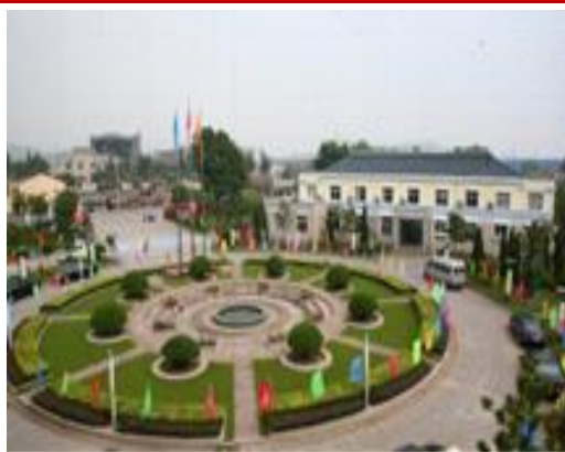
图5：马鞍山市第二污水处理厂TOT项目
