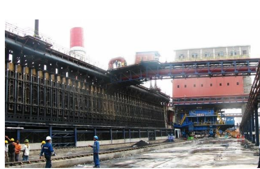
图 6：印度 JSW 钢厂 150 万吨捣固焦炉及化产回收工程
