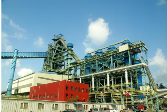
图 5：土耳其 ISDEMIR3050m3 高炉项目总承包
