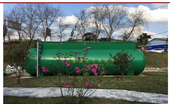
图 4: 江西省会昌县污水处理厂二期项目
