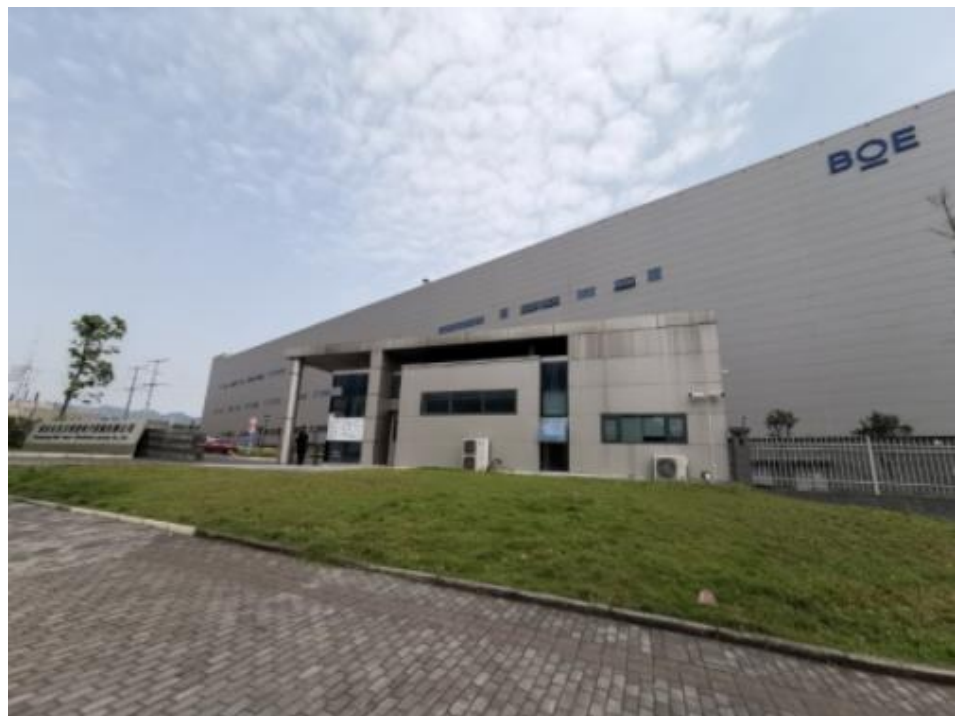
图 4：京东方园区及自有 220kV 变电站
