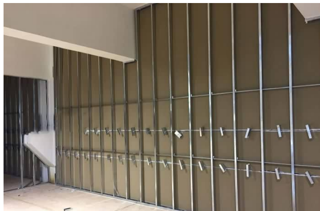
图 16：现代石膏板隔墙
