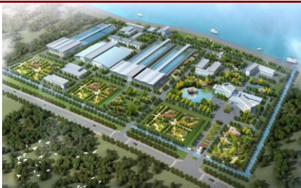
图 15: 苏州张家港纳滤深度处理厂项目
