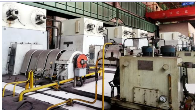
图表 35 禾望大功率变频器应用于轧钢主轧设备
