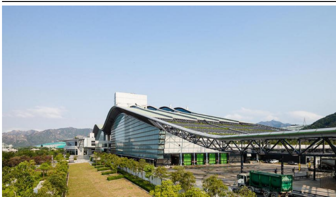
图 52：威立雅中国香港污水处理项目
