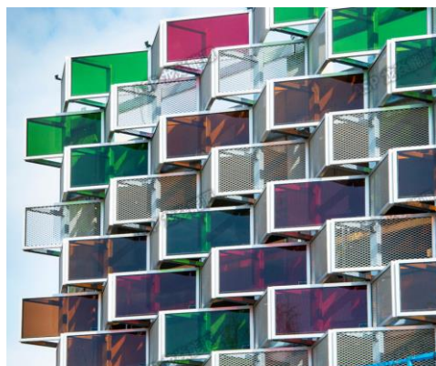
图 16：龙焱瑞典光伏小镇彩色幕墙项目
