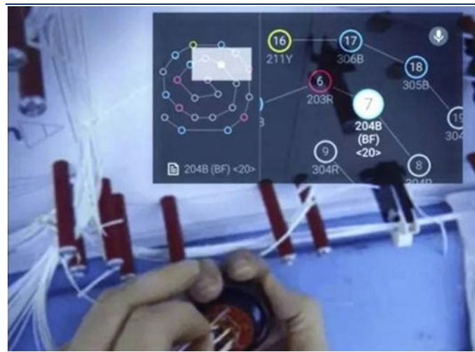
图 73: 工人按照谷歌眼镜的提示进行布线
