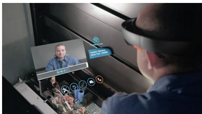
图 74：工人使用 Hololens 眼镜安装、检修电梯
