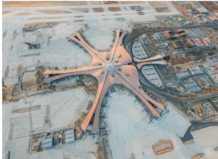
图 30：北京大兴国际机场
