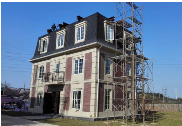
图 28：Bhouse——多屋全装配建筑结构体系
