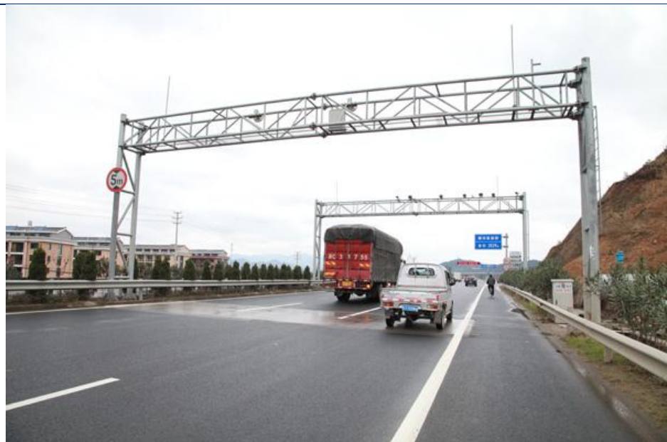
图 26：国内首台公路车辆超限非现场执法设备在浙江台州落成
