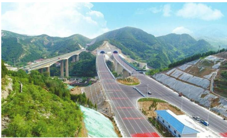
图 37: 山东滨莱高速测试场地
