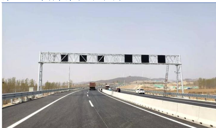
图 35：山东滨莱高速公路测试场地
