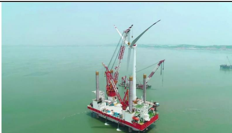
图表34：明阳智能MySE5.5-155风电机组在兴化湾完成吊装
