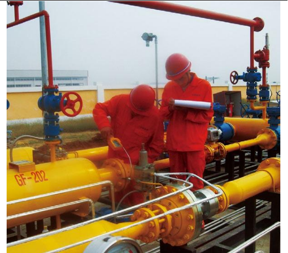
图 59: 长输管道检修作业
