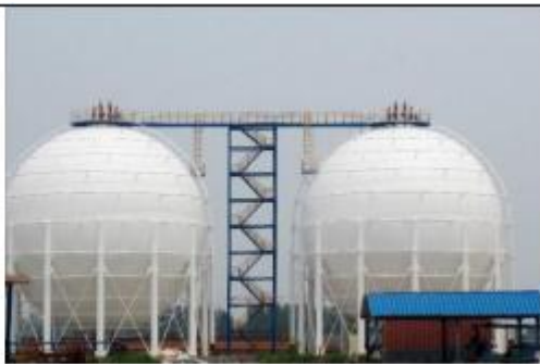
水性防腐涂料应用于垦利石化储罐
