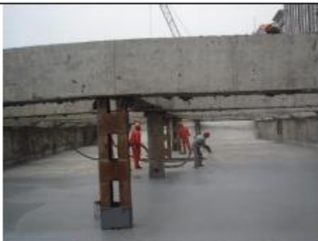
喷涂聚脲弹性体材料应用于上海外滩隧道项目
