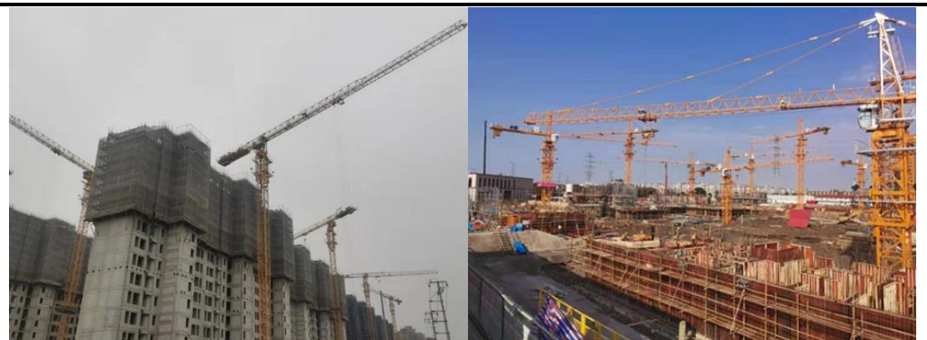
图表38：装配式建筑工地上塔机密度较高
