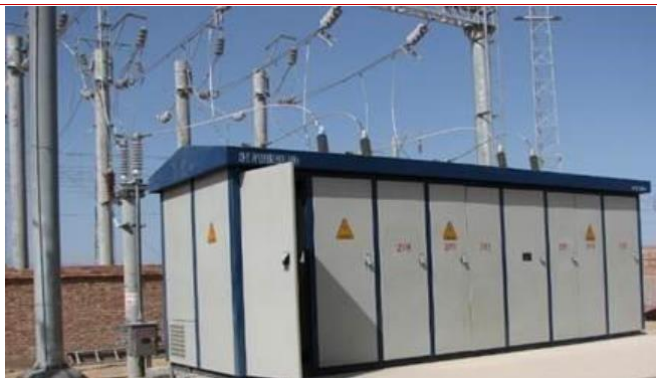
图表 55: 箱式分区所现场照片
