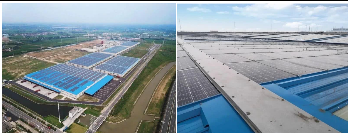
图表25. 东方日升金坛二期工厂 BIPV 项目
