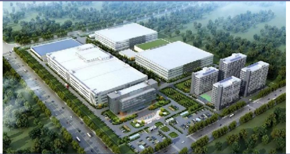
图 31、景旺电子珠海高多层/HDI 产业化项目
