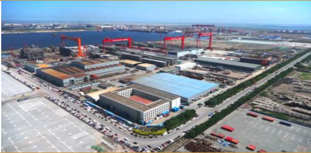
图 15：博迈科 2#码头施工现场
