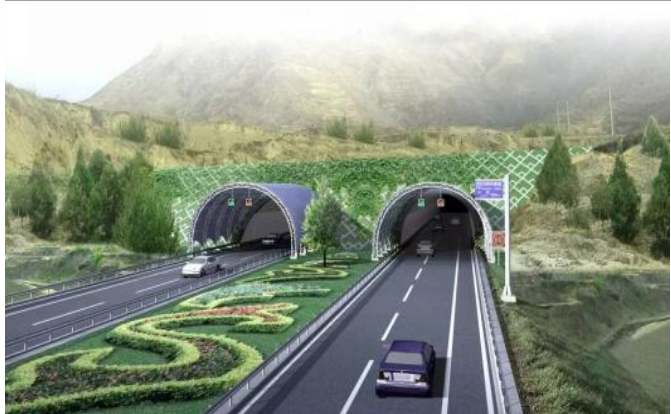
图表32：云南华丽高速公路营盘山隧道
