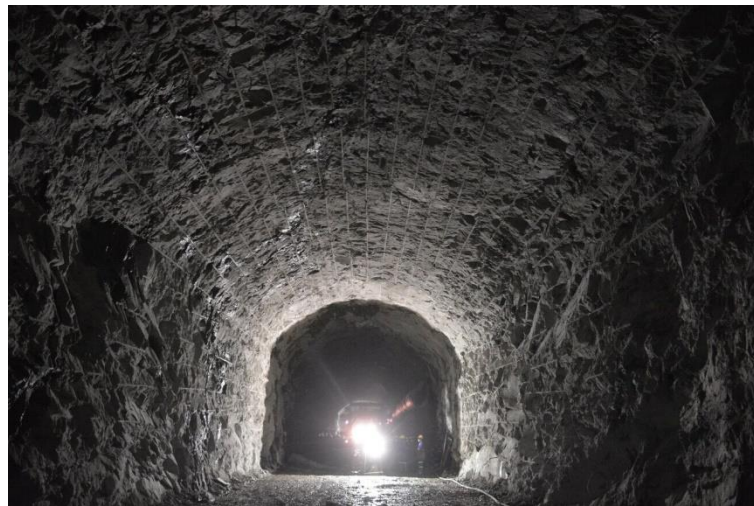
图 27：光面爆破图片
