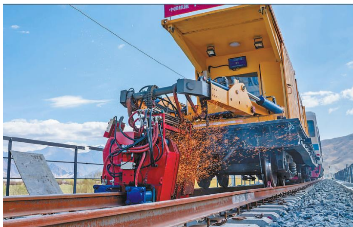
图 25：川藏拉林段长钢轨无缝焊接
