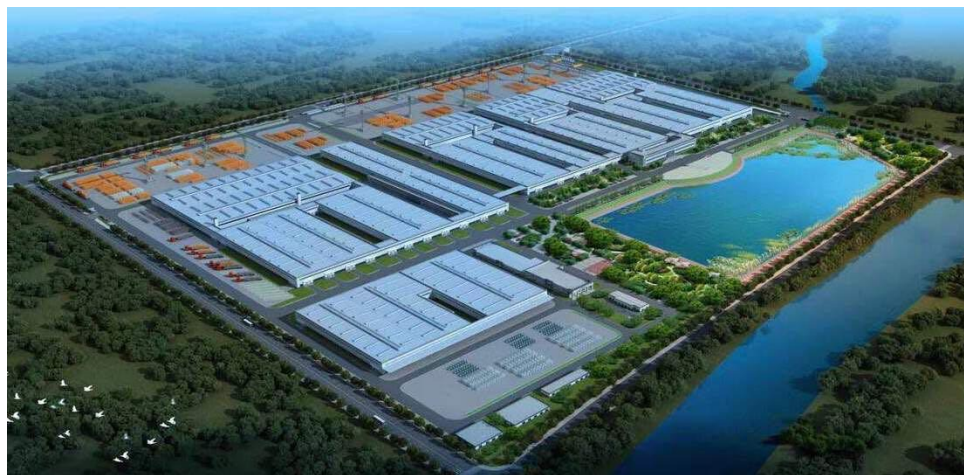
图 49：中联重科塔机智能工厂二期项目
