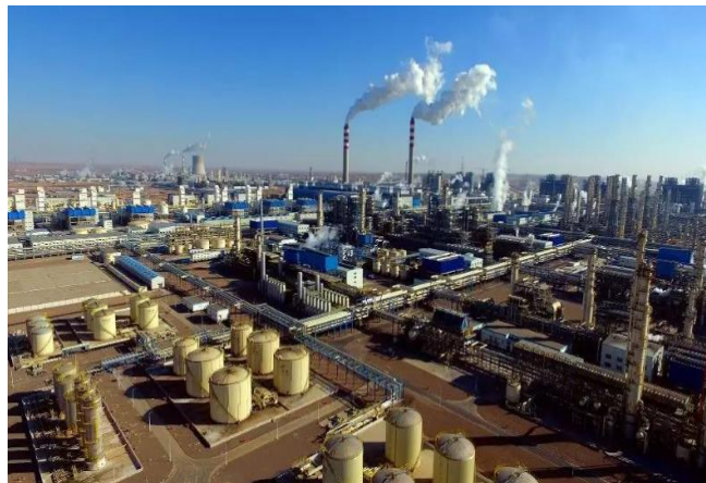
图 25：神华宁煤集团 400 万吨/年煤炭间接液化示范项目
