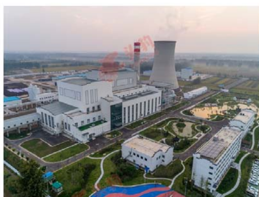
图 5-1 灵璧生物质及垃圾发电一体化项目
