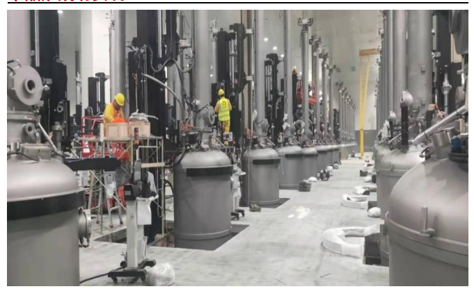
图 38: 2019 年 10 月 10 日, 弘元新材 5GW 单晶项目第一台单晶炉成功安装
