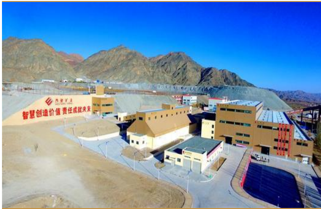
图 50：锡铁山铅锌矿实景图
